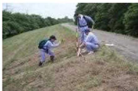
河川管理施設の点検（国管理河川では出水期前に加え、台風期前、洪水後、地震後などにも実施）
