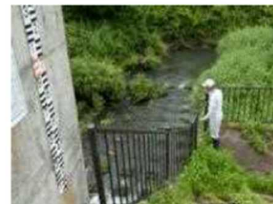
河川管理施設の点検（国管理河川では出水期前に加え、台風期前、洪水後、地震後などにも実施）
