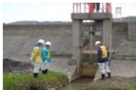
河川管理施設の点検（国管理河川では出水期前に加え、台風期前、洪水後、地震後などにも実施）
